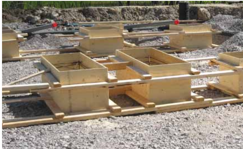
Kuva 3 Paaluanturoiden muotit.
