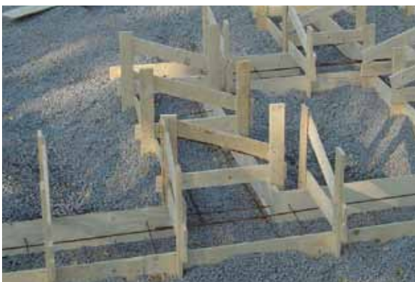
Kuva 7 Matala anturamuotti sahatavarasta.
