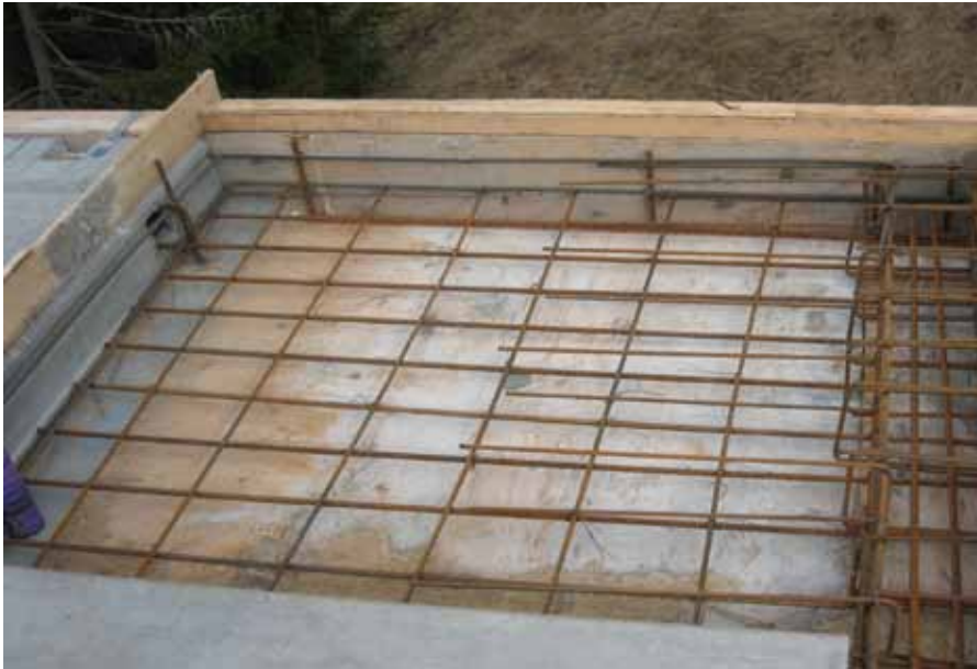
Kuva 9 Ontelolaattavä-lipohjan paikallavaletta- van osan raudoitusta ja muotti.
