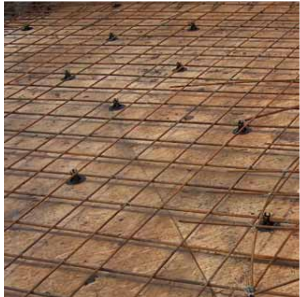
Kuva 10 Raudoituskorokkeet pitävät raudoitusverkon suojaetäisyyden päässä muotista.
