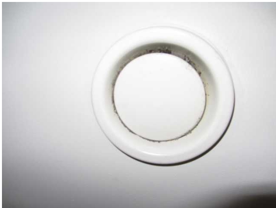
Kuva 25. Poistoilman päätelaitteet tulee puhdistaa säännöllisesti. Jos päätelaite on säädetty hyvin lähelle kiinni-asentoa, voi rakoon kertyvä lika tukkia laitteen ja ilmanvaihto heikkenee.
