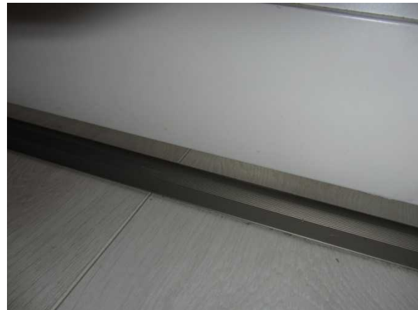
Kynnyksen tilalla on peitelista ja oven ja lattian väliin jää riittävä ovirako siirtoilmalle.
