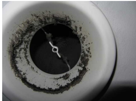
Kuva 25. Poistoilman päätelaitteet tulee puhdistaa säännöllisesti. Jos päätelaite on säädetty hyvin lähelle kiinni-asentoa, voi rakoon kertyvä lika tukkia laitteen ja ilmanvaihto heikkenee.
